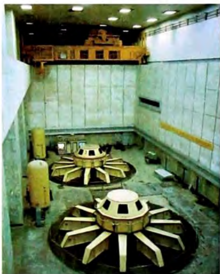
Токтогул ГЭСинин турбиналары.
